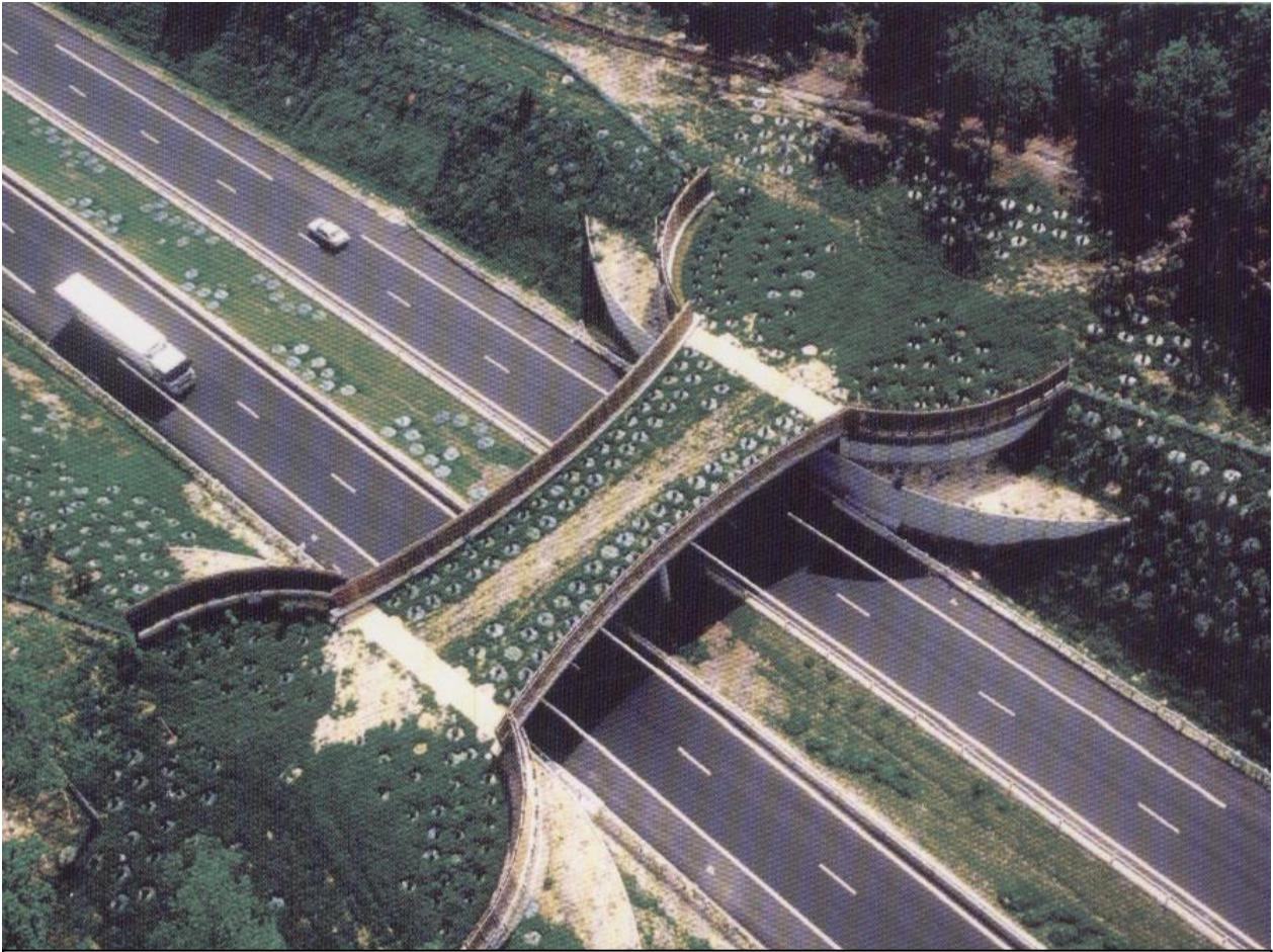
Exemple de passage à grande faune sur l'A77
