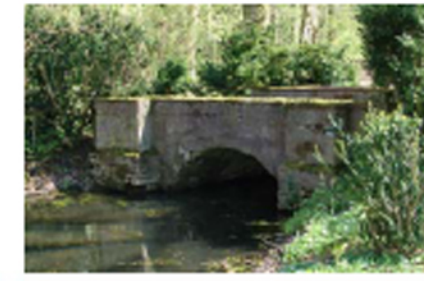
Petit pont sur fossé secondaire
